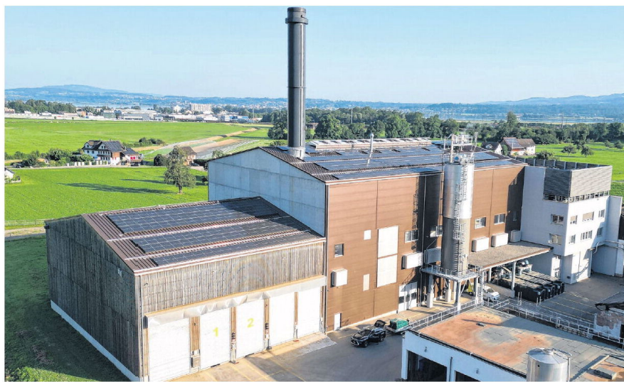
Das Holzwerkstoffwerk der Energie Ausserschwyz AG in Galgenen ist seit 2022 in Betrieb und produziert erneuerbaren Strom und Wärme für die Region.
